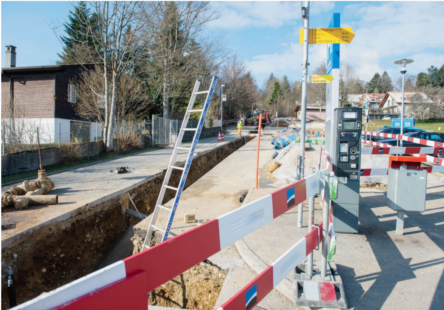
Die Bauarbeiten werden voraussichtlich bis im November 2022 dauern. PETER SAMUEL JAGGI
