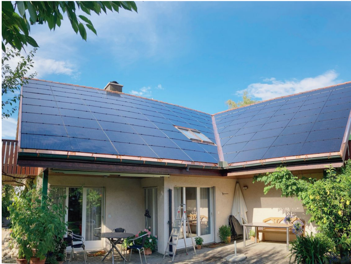
Viel Sonne und grosse Dächer: In Müntschemier sind Solarpanels im Trend. zvg
