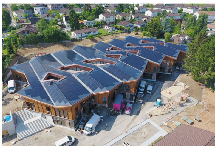
Die Solarpanels auf dem Dach der Neuen Schule Port umfassen eine Fläche von 1800 Quadratmetern. zv
