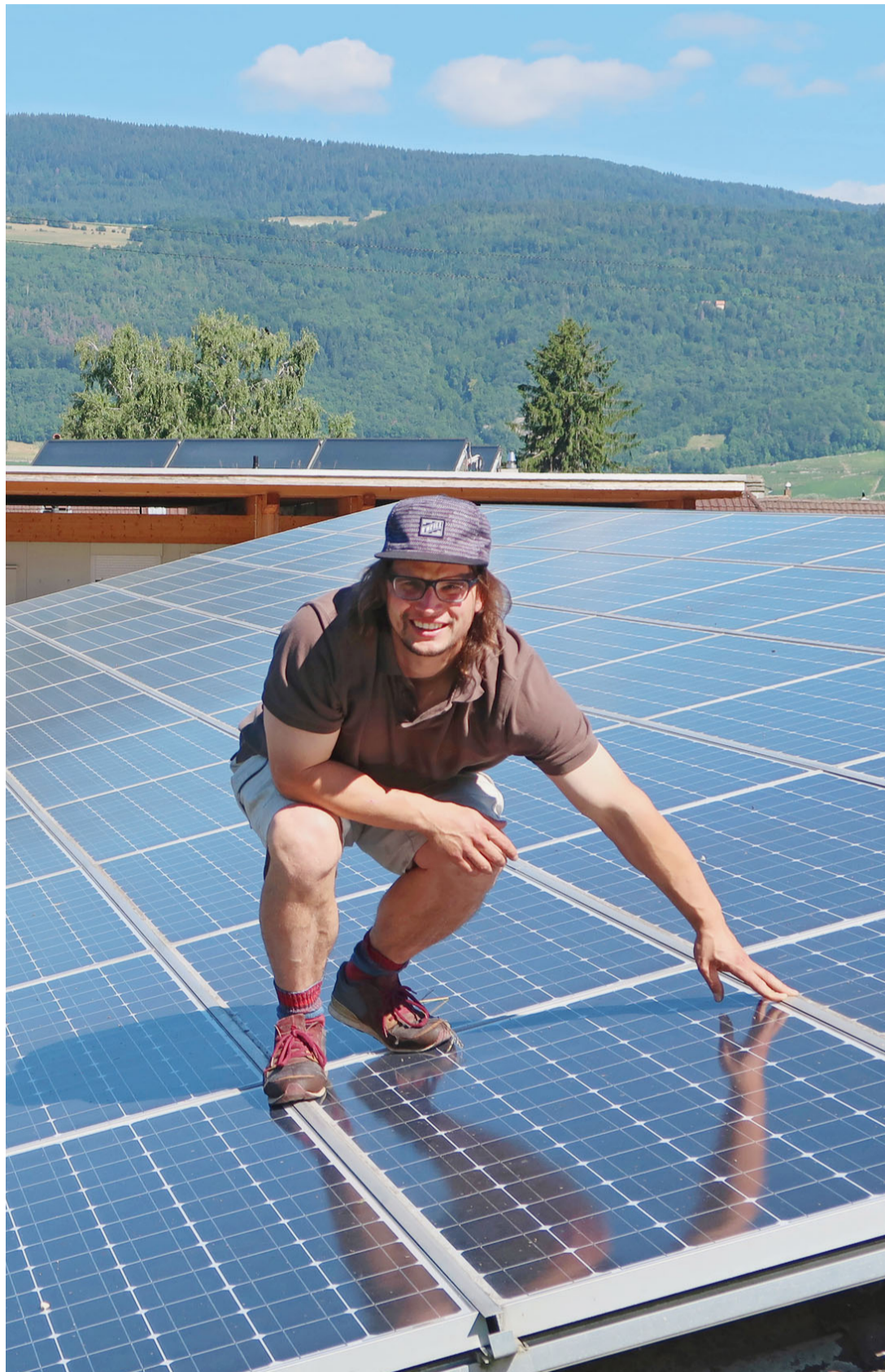
Selbstversorgung: Der Galser Patrik Niederhauser hat seine Eltern überzeugt, auf Fotovoltaik zu setzen. Nun produzieren sie mehr Strom, als sie verbrauchen. Peter Staub
